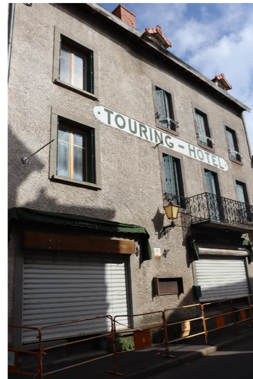
Réaménagement d'un ancien hôtel (projet interrompu)
